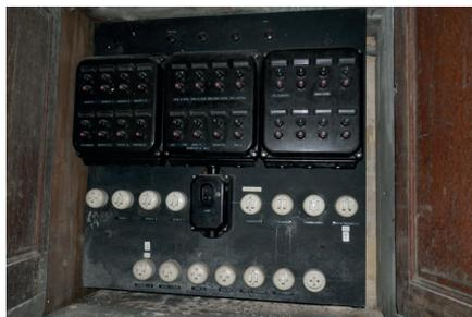
Un tableau électrique vétuste. La conformité de l'ensemble de l'installation électrique doit être contrôlée.
