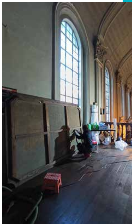
Fig. 56. Vue d'un chantier provisoire au-dessus du jubé : en cours d'aspiration des moisissures.
